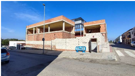
Construcción existente desde la esquina de ambas calles
