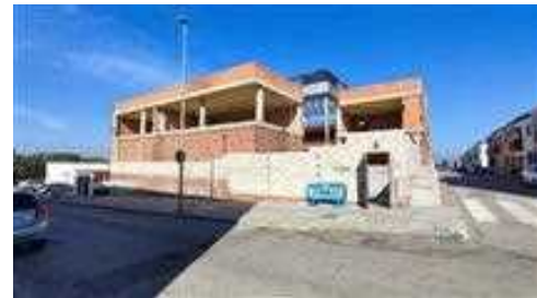
Construcción existente desde la esquina de ambas calles
